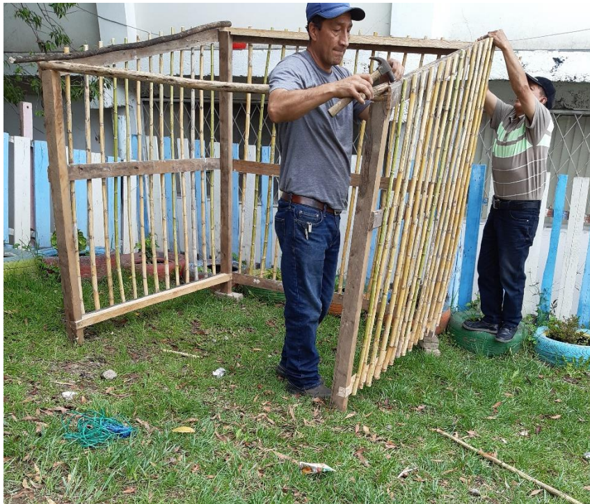
Figura 12. Construcción de la casa de madera y carrizo para el área de “La cocinita (mi choza)” dentro del espacio: Atelier del “Wawa”. Documentación del investigador.
