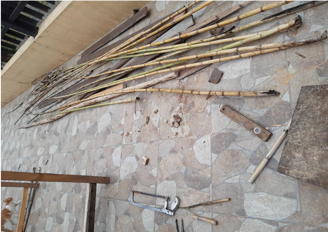
Figura 11. Construcción de la casa de madera y carrizo para el área de “La cocinita (mi choza)” dentro del espacio: Atelier del “Wawa”. Documentación del investigador.
